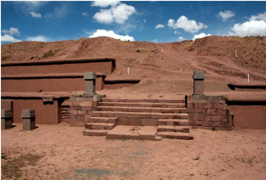
Figura 16 - Entrada Oeste de Akapana.
